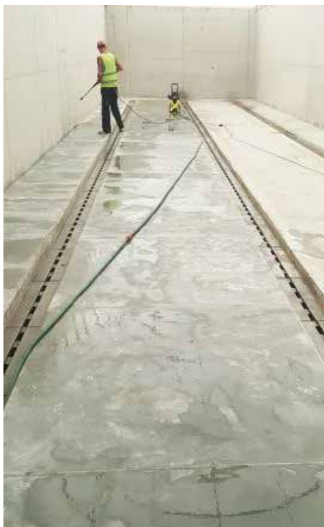
Zakład unieszkodliwiania odpadów Katowice AS-S100 N-0 - 4020 mb
