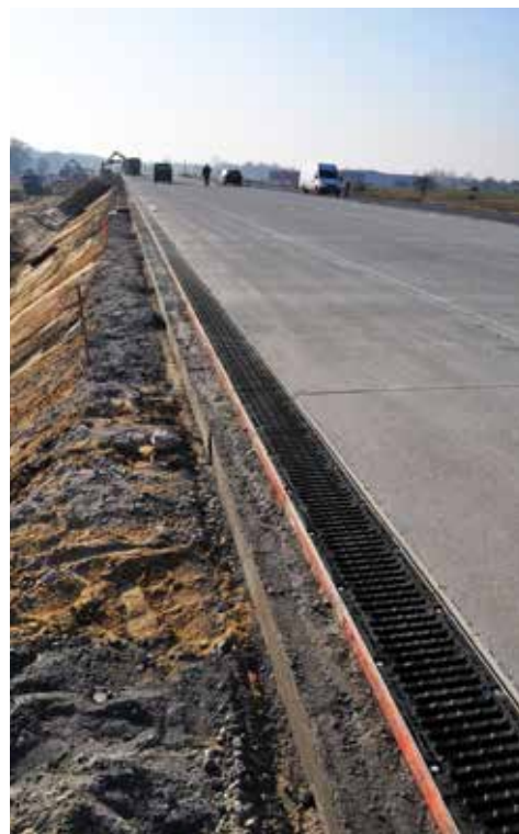
Droga Ekspresowa S8 Zawada AS-200 - 900mb
