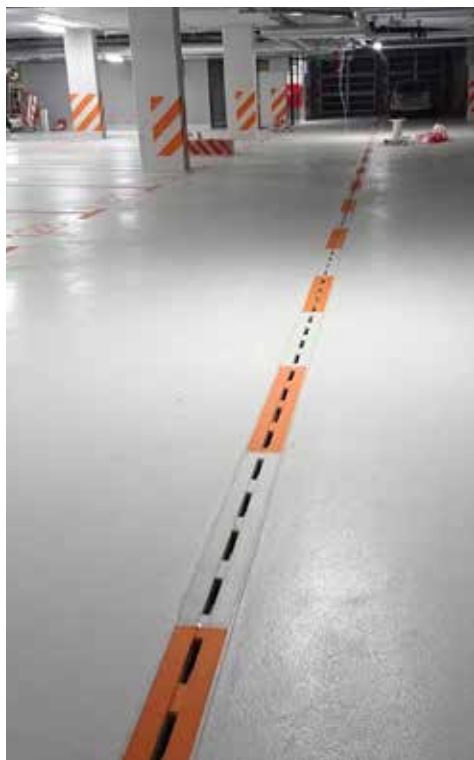
Garáže podziemne AS-A-S100
