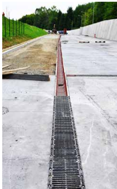
Składowisko Odpadów Komunalnych Barycz AS-300 - ponad 700mb
