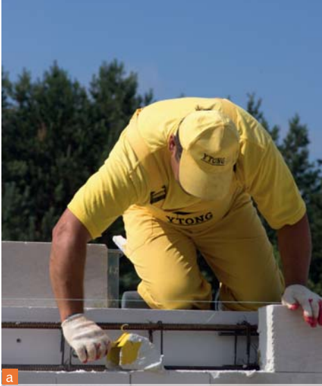
a Mury z bloczków z betonu komórkowego przeznaczone do wznoszenia ścian jednowarstwowych z cienkimi spoinami. Dzięki powierzchni czołowej profilowanej na pióro i wpust, spoiny pionowej nie wypełnia się zaprawą (a). Dodatkowo w powierzchniach czołowych wyfrezowane są uchwyty ułatwiające przenoszenie i ustawianie bloczków (b)
