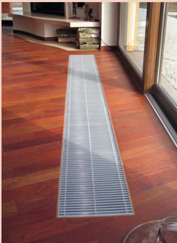
▲ Grzejnik umieszczony w kanale pod oknem balkonowym tworzy kurtynę z ciepłego powietrza chroniącą wewnątrz przed chłodem
