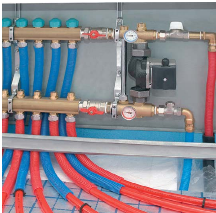
Każdy obwód grzejny ma swój początek i koniec w rozdzielaczu: czerwone – końcówki zasilające, niebieskie – końcówki powrotne
