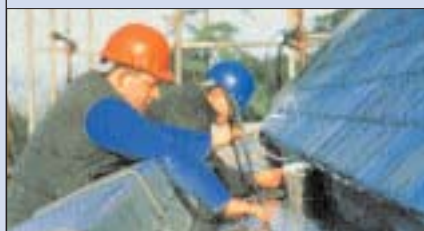
14 Układanie przewodów grzewczych na dachu (fot. Raychem)
