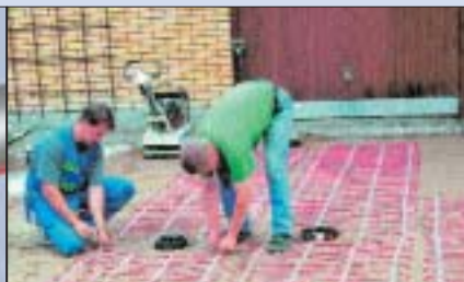
13 Montaż ogrzewania przeciwołdzeniowego najlepiej wykonać równoległe z robotami budowlanymi (fot. Devi)
