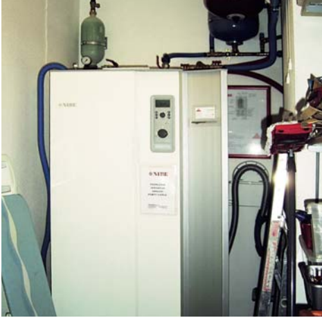
▲ Pompa ciepła o mocy 6 kW to urządzenie kompaktowe, w którym mieści się 160 litrowy zasobnik ciepłej wody użytkowej. Współpracuje z kolektorem poziomym długości 400 metrów (dwie pętle po 200 metrów)
