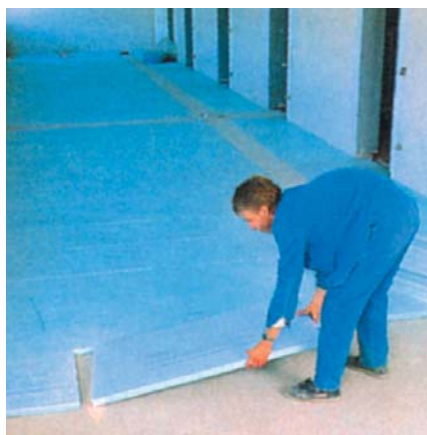
13 Polistyren ekstrudowany jest niemal niezastąpiony przy izolowaniu podłóg (fot. DOW) ▲
