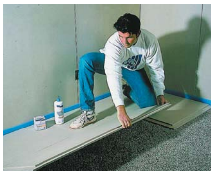
15 Suchy jastrych gipsowy doskonale się sprawdza w modernizowanych domach (fot. Rigips) ▼
