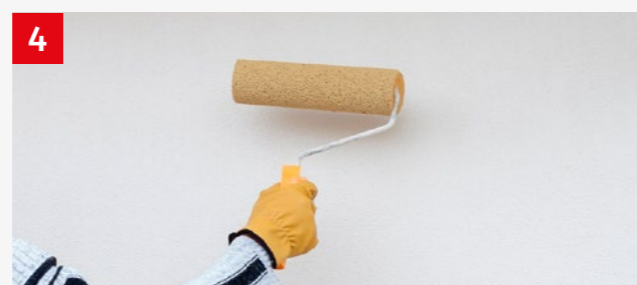
Impregnacja elewacji preparatem Funcosil WS
