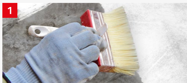
Naniesienie na elewację preparatu czyszczącego Clean SL
