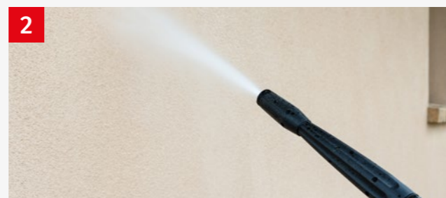
Splukanie elewacji czystą wodą
