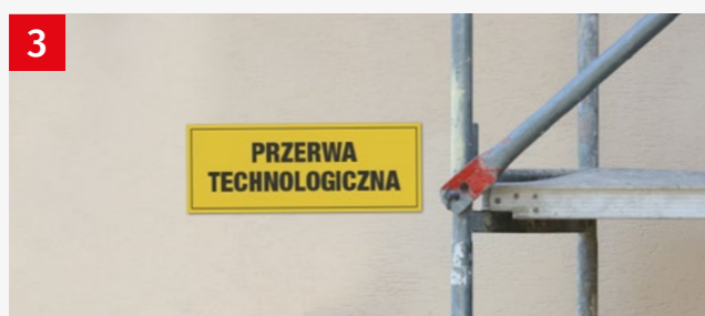
Pozostawienie elewacji do pełnego wyschnięcia
