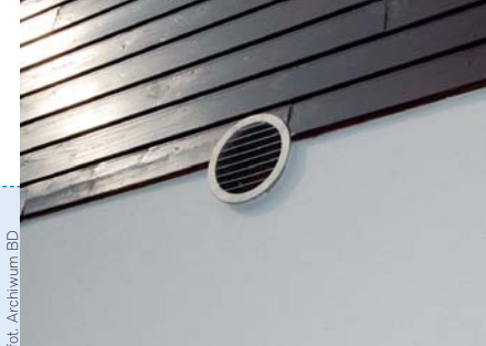
Wyrzutnia powietrza zamontowana w ścianie szczytowej
