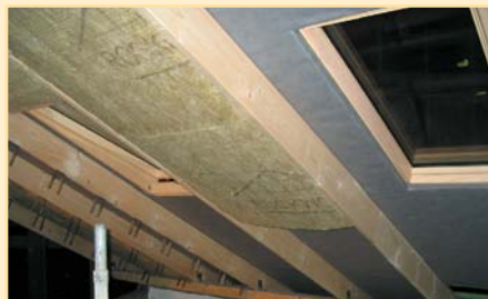
Płyty TOPROCK same utrzymują się między krokiewmi
