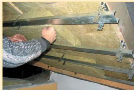
Pod krokiewmi i między elementami stalowego rusztu montujemy drugą warstwę ocieplenia
