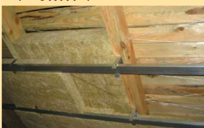
Szczelina wentylacyjna i ruszt ze sznurka zapobiegający jej zapchaniu
