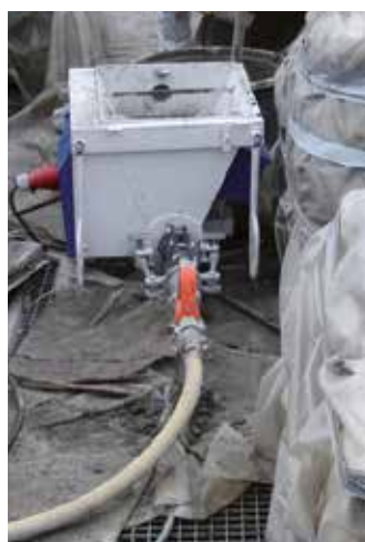
Maszynowa aplikacja Silicate R
