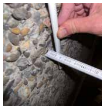
Podłoże oczyszczone po użyciu myjki wysokociśnieniowej
