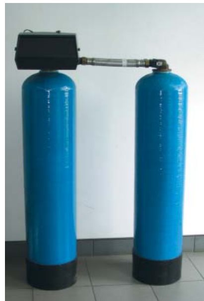
▲ Wymiennik jonitowy dwukolumnowy służy do usuwania twardości wody bez konieczności przerywania procesu uzdatniania na czas regeneracji złoża
