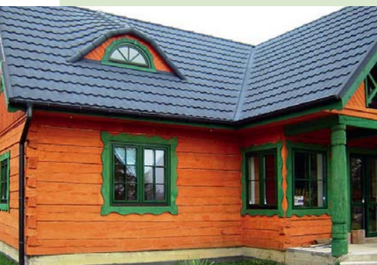
foto: Ahi Roofing
