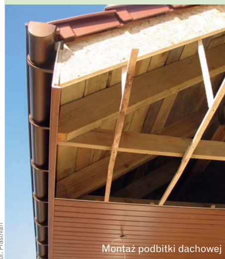
Listwy wentylacyjne z małymi szczelinami (kratkami), przez którą wpada powietrze. Kratki powinny być na tyle małe, by nie przedostawały się przez nią owady. Najlepiej, jeśli wentylacja umieszczona jest co dziesiąty element podbitki dachowej
