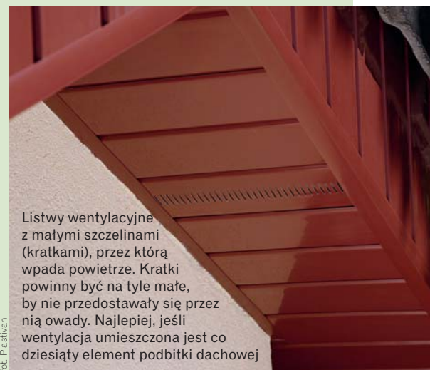
Montaż podbitki dachowej
