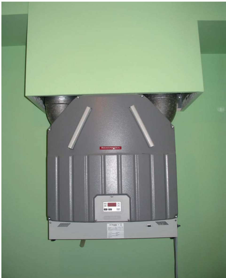
Nowoczesny rekuperator przeciwprądowy zapewniający ponad 95% odzysk ciepła w systemie rekuperatory.pl.
