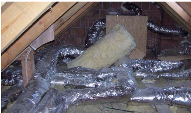
Instalacja wykonana z złej jakości przewodów może hałasować lub zamiast oczekiwanej oszczędności energii przynosić znaczne straty
