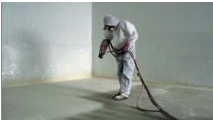
6 Nałożona metodą natryskową pianka poliuretanowa twardnieje w ciągu kilku sekund (fot. Pluimers)
