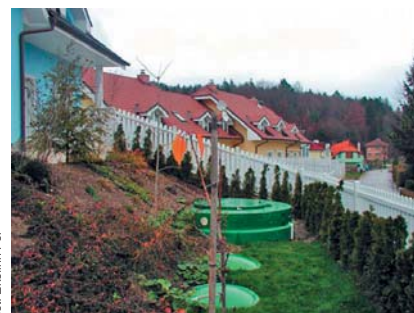
Oczyszczalnia kompaktowa (na zdjęciu ze złożem biologicznym) zajmuje niewiele miejsca, a ścieki są oczyszczone w bardzo wysokim stopniu
