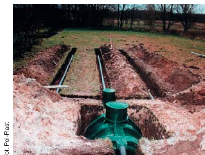
Tak wygląda drenaż rozsączający w gotowym wykopie
