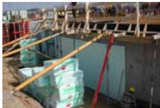
izolacja ściany fundamentowej
