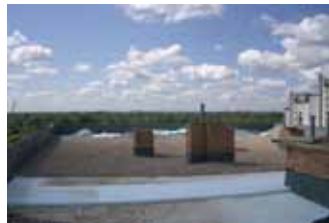
izolacja dachu płaskiego
