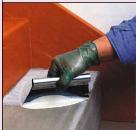
5 Najmocniej wiążące i szybkoschnące kleje stosuje się do przyklejania wykładzin na schodach (fot. Mapei)
