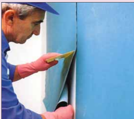
4 Spoiny utworzone przez kleje do tapet osiągną pełną wytrzymałość po około 24 godzinach (fot. Mapei)
