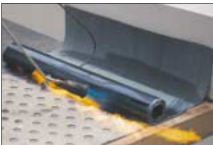
1 Termozgrzewalna papa dachowa (fot. archiwum BD)
