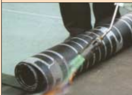
3 Elastomerobitumiczna papa renowacyjna jednowarstwowego krycia, zgrzewana (fot. Bauder)
