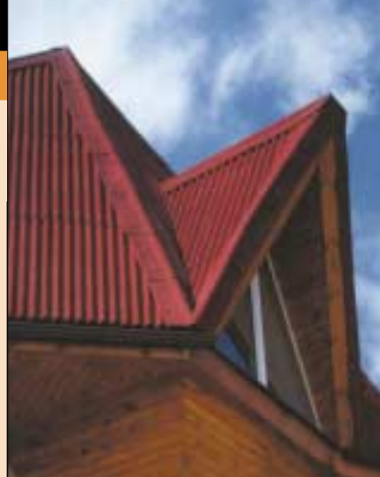
4 Dach kryty bitumicznymi płytami falistymi (fot. Onduline)
