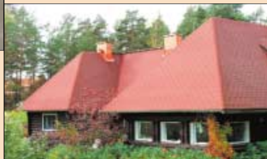
5 Dach kryty gontami bitumicznymi (fot. Icopal)
