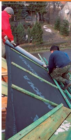
5 Najczęściej folię paroprzepuszczalną mocuje się bezpośrednio do krokwi (fot. Marma Polskie Folie)
