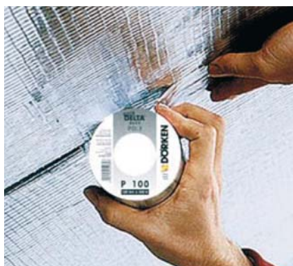
Regulator antykondensacyjny jest odpowiednikiem FWK o wysokiej paroprzepuszczalności; zapewnia powolne przenikanie pary i zapobiega powstawaniu skroplin (fot. Marma Polskie Folie)
