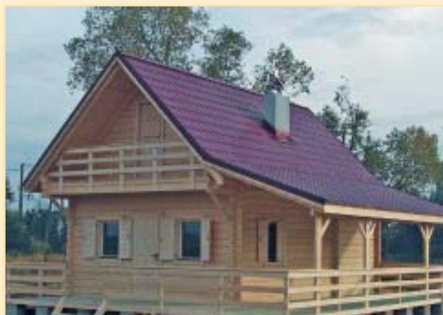
15 Tradycyjne okiennice mogą w istotny sposób ograniczać straty ciepła przez okna (fot. BuDrev)
