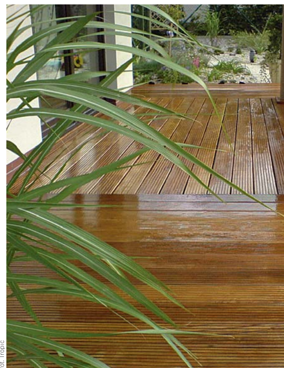
▲ Taras na gruncie wykonany z drewna egzotycznego garapa
