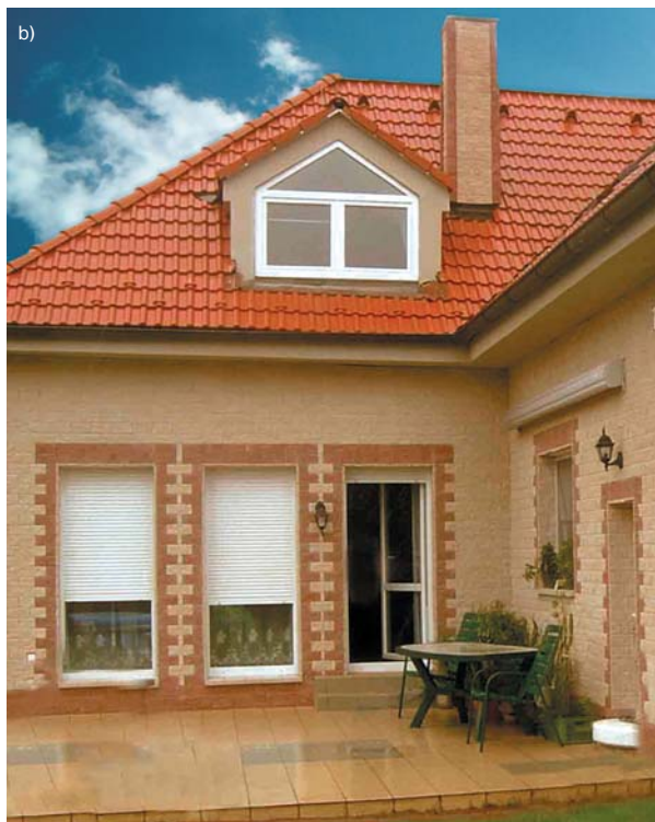
Płytki elewacyjne w różnych fakturach i kolorach mogą imitować np. cegłę (a) lub klinkier (b)
