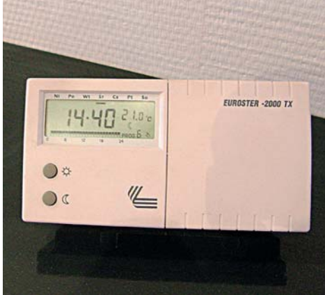
▲ Programator Euroster ustawiony jest na jednej z szafek w salonie. Dzięki niemu można zmieniać nastawy pompy ciepła
