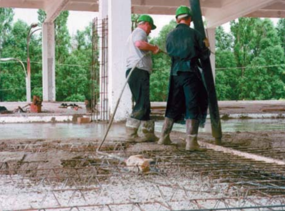
▲ Szalunkowe płyty stropowe typu filigran; zalewanie stropu betonem
