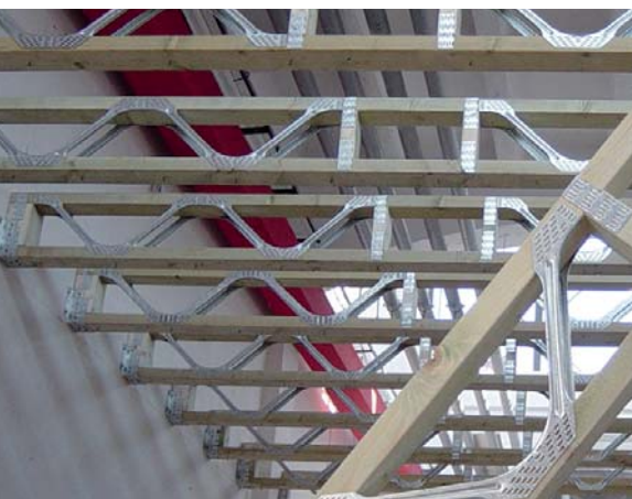
▼ Prefabrykowane drewniane belki stropowe
