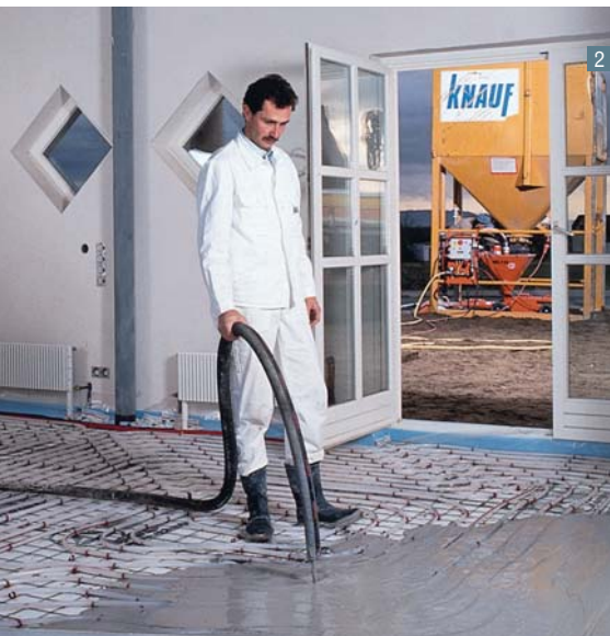
▲ Wylanie podkładu podłogowego. Czynność tę powinna poprzedzić decyzja o rodzaju przyszłego pokrycia podłogi oraz o tym, czy w podłozie będzie ogrzewanie
