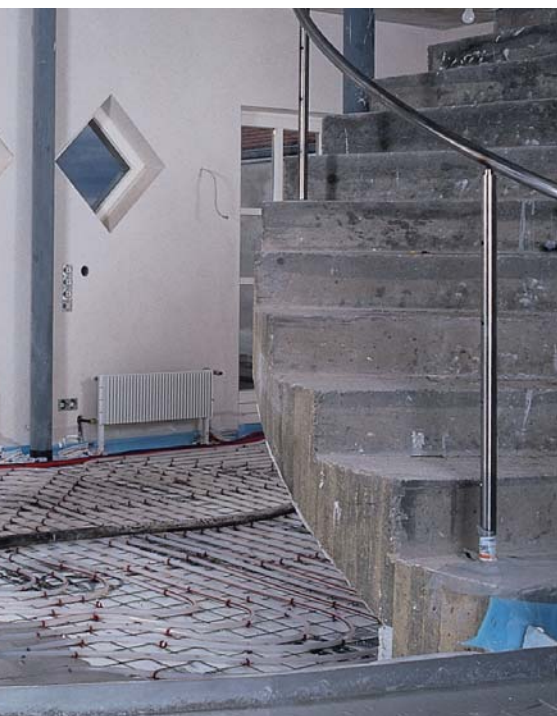
▼ Schody betonowe wylewa się po zabetonowaniu stropów
