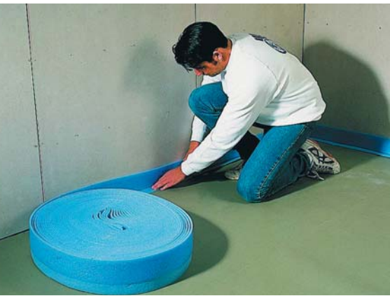
▲ Przed wylaniem betonu należy ułożyć paski dylatacyjne wzdłuż wszystkich ścian
