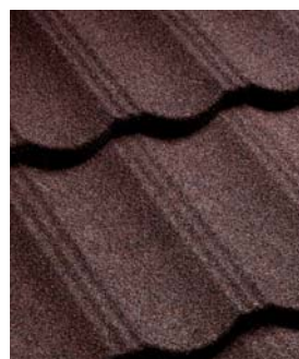
foto. AHI ROOFING
