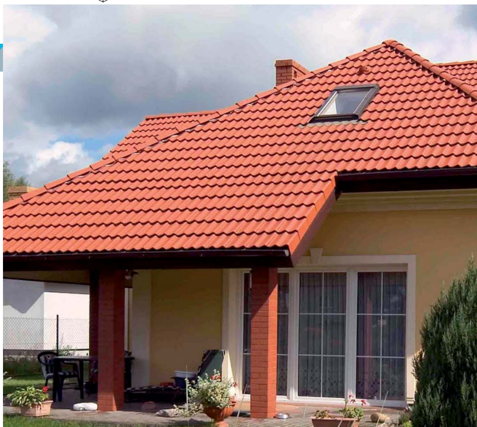
▲ Dachówki cementowe. Przypominają ceramiczne, ale są od nich większe i lżejsze. Zalecany kąt nachylenia połaci dachu to 22-60°
