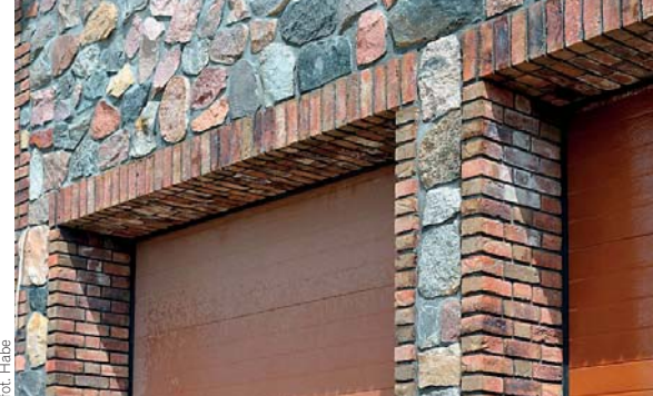
▲ Przykład elewacji murowanej – efektowne połączenie cegły z kamieniem
