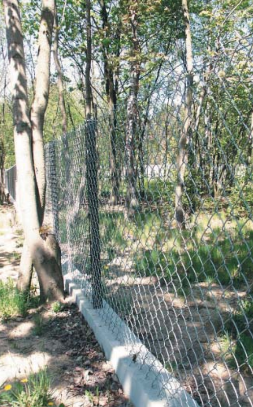
▲ Siatka pleciona z drutu ocynkowanego z oczkami o układzie diagonalnym
