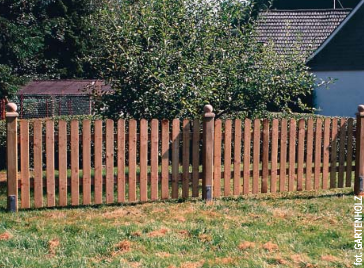
▲ Wypełnienie paneli drewnianych stanowią najczęściej pionowe sztachety połączone poziomymi deskami
