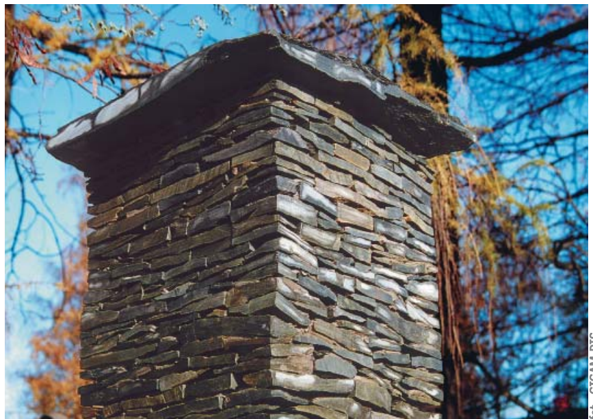
▲ Kamień w murze układa się poziomymi warstwami z przewiązywaniem spoin.
