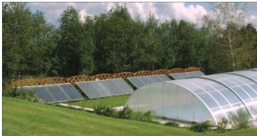
16 Kolektory służące do podgrzewania wody w basenie, ustawione na ziemi (fot. Hewalex)
