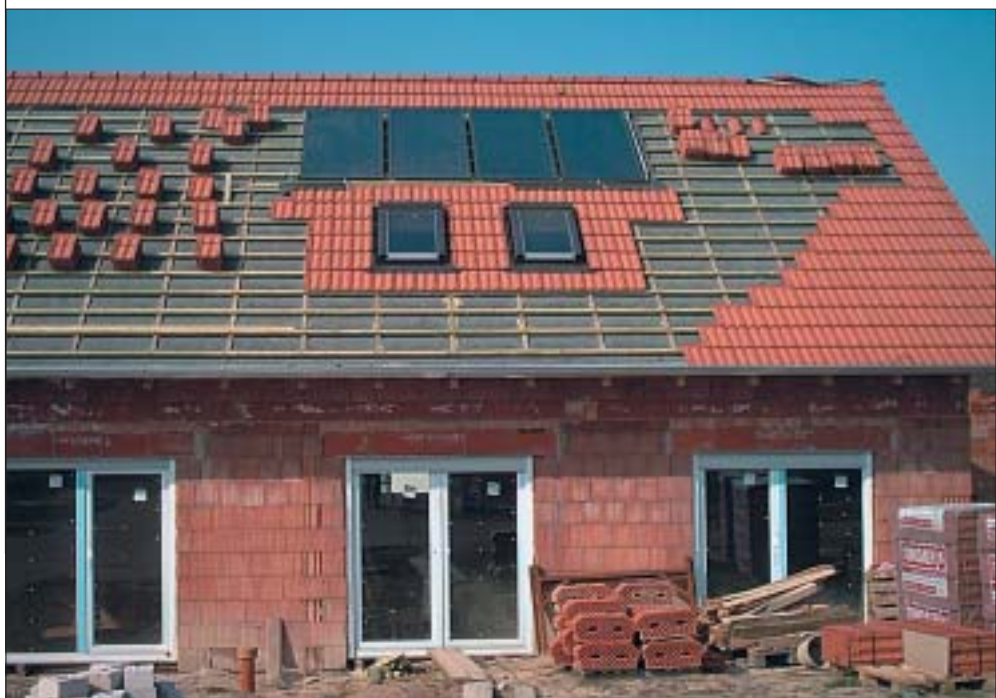
15 Kolektory wbudowane w połac dachu (fot. Harond Przedsiębiorstwo Innowacyjno Wdrożeniowe)
