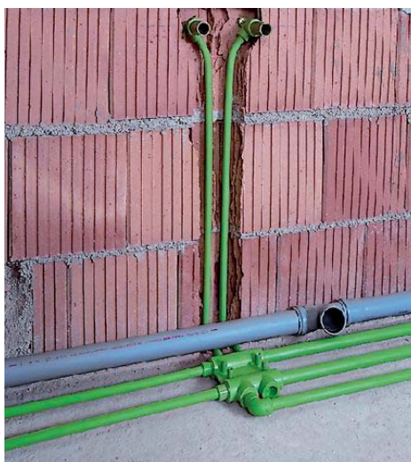
▲ Rury do zimnej i ciepłej wody mogą być prowadzone w posadzce
