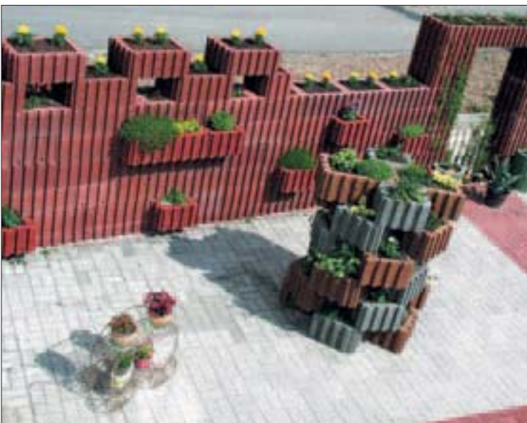
1 Różne kształty gazonów pozwalają nie tylko na wykonanie murka oporowego, ale i na skomponowanie donic na rośliny (fot. Joniec)
