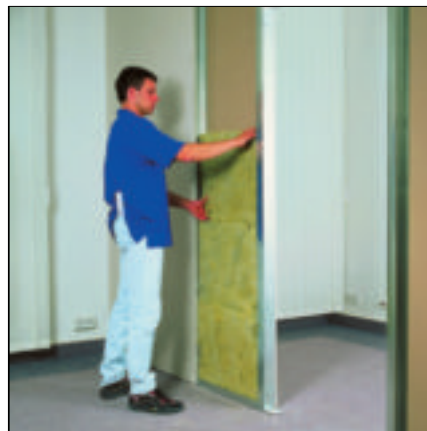
2 Konstrukcję ścian szkieletowych buduje się najczęściej ze stalowych profili (fot. Rigips)
