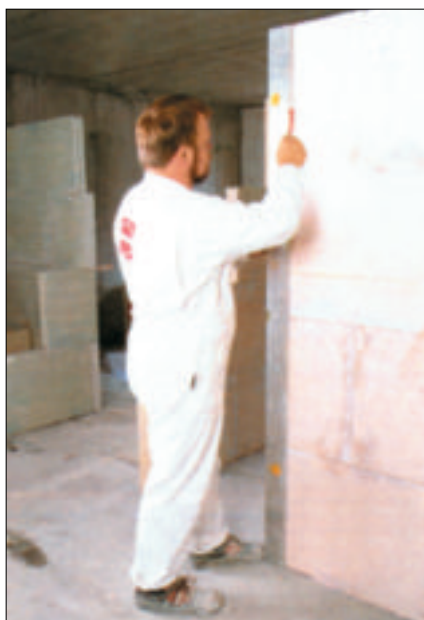
3 Ściany z płyt gipsowych są łatwe w montażu (fot. Orth-Gipse)
