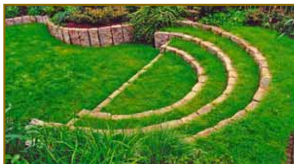
Podstopnice wykonano z kamieni, pomiędzy którymi ułożono darń. Takie rozwiązanie będzie pracochłonne w utrzymaniu ze względu na utrudnione koszenie trawy, jednak niewątpliwie urok takich schodów wart jest poświęcenia (fot. Ogrody Dankiewicz)
