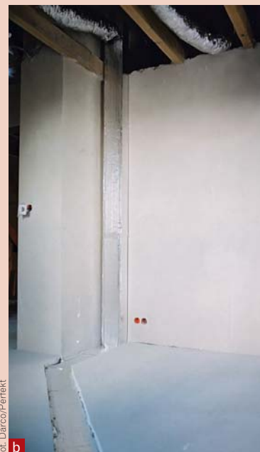
▲ ▲ Rury sztywne izoluje się płytami z wełny mineralnej pokrytej folią aluminiowo-poliestrową. Izolację tę umieszcza się na każdej ścianie rury, także od strony ściany budynku (a). Kształt rur o przekroju prostokątnym pozwala zaoszczędzić sporo miejsca (b)
