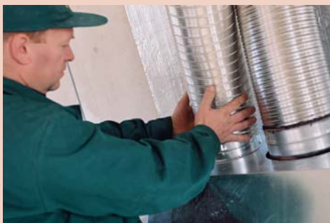
▲ ▲ Podłączenie rur dystrybuujących gorące powietrze z wkładu
