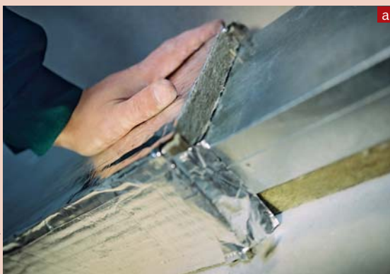
◀ Rura sztywna może także doprowadzać powietrze zewnętrzne lub powrotne z pomieszczeń. Ją, tak jak rury rozprowadzające gorące powietrze, także trzeba zaizolować. W tym przypadku izolację stosuje się, aby nie dochodziło do wychłodzeń w miejscach jej połączenia
