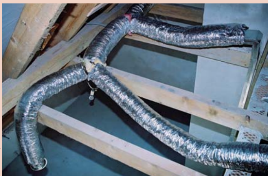
▲ Rury poprowadzone w pomieszczeniu nieogrzewanym muszą być zaizolowane
