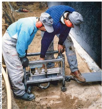
Wbijanie blach może wymagać odsłonięcia fundamentów
