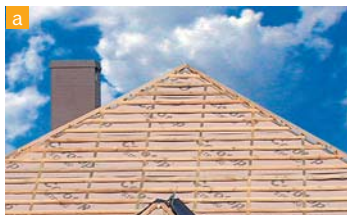
▲ Skuteczną wentylację pod pokryciem dachowym umożliwiającą: ruszt z łąt i kontrłat (a), wywietrzniki kalenicowe ze szczotką (b), specjalne kominki montowane w miejscach, w których wentylacja jest utrudniona (c)
