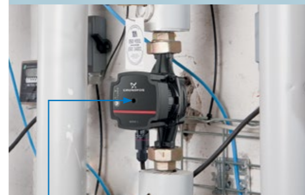
Otwór do ręcznego odblokowywania wału i wirnika pompy za pomocą wkrętaka
