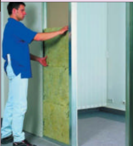
10 Wkładanie wełny mineralnej między profile CW (fot. Rigips)
