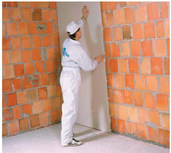
4 Dzięki płytom gipsowo-kartonowym ściany będą równe, a przy okazji można zatuszować niewielkie nierówności podłoża (fol. Rigips)
