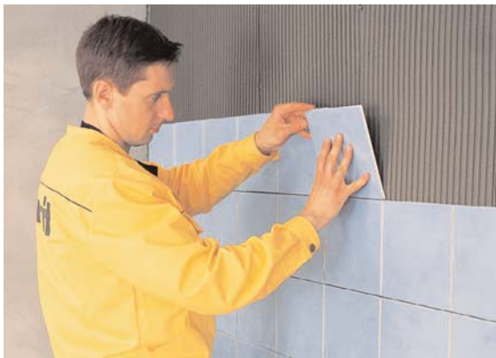
9 Kafelki będą się dobrze trzymały, gdy zaprawę klejową wyrównamy zębatą pacą (fot. Henkel)
