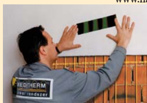
Oznaczenie rurek pod tynkiem
