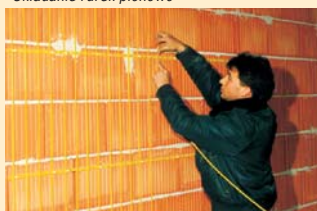
Układanie rurek pionowo
