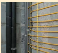
Układanie rurek poziomo
