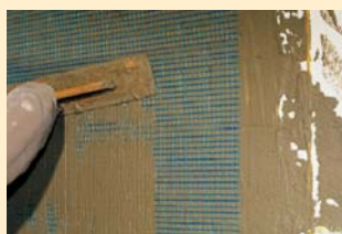
Naciąganie gładzi tynkowej
