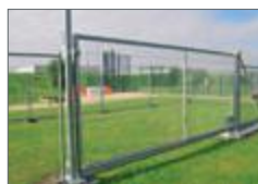
Tymczasowa brama przesuwana
