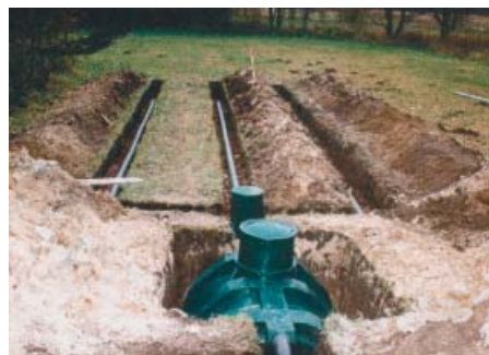
Tak wygląda drenaż rozsączający w gotowym wykopie (fot. Poz-Plast)
