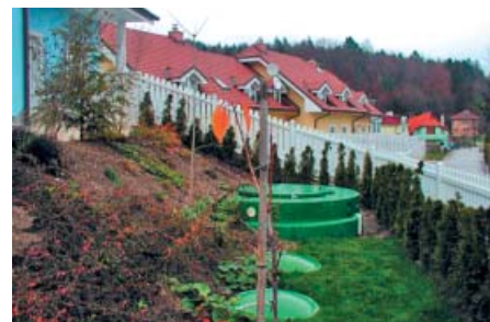
Oczyszczalnia kompaktowa (na zdjęciu ze złożem biologicznym) zajmuje niewiele miejsca, a ścieki są oczyszczone w bardzo wysokim stopniu (fot. Ekofinn-Pol)
