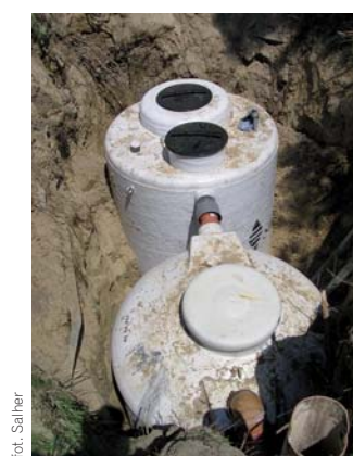
Oczyszczalnia umieszczona w wykopie
