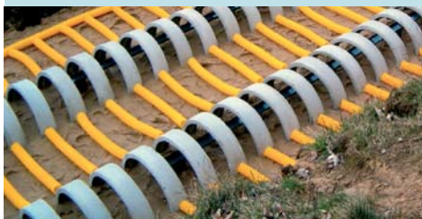
Filtr piaskowy z rozsączaniem grawitacyjnym
