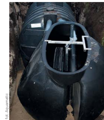
Oczyszczalnia umieszczona w wykopie
