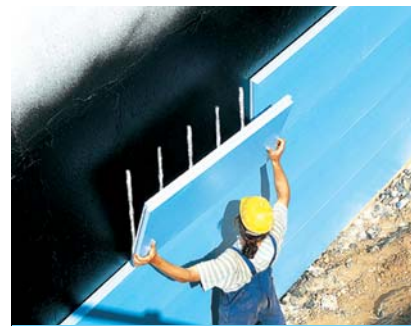
Montaż płyty termoizolacyjnej na fundamencie
