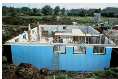
Izolacja fundamentów
