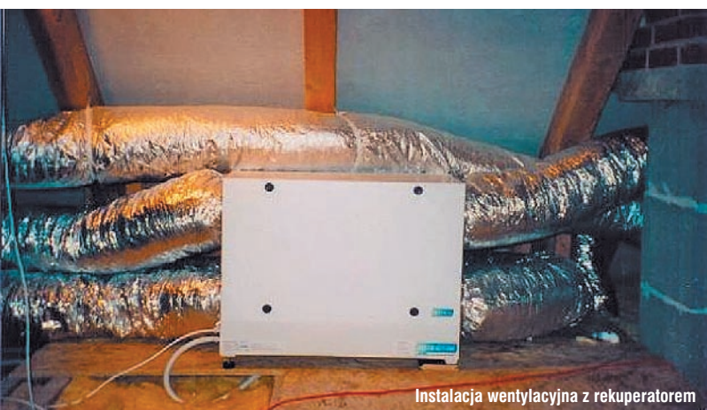
Instalacja wentylacyjna z rekuperatorem
