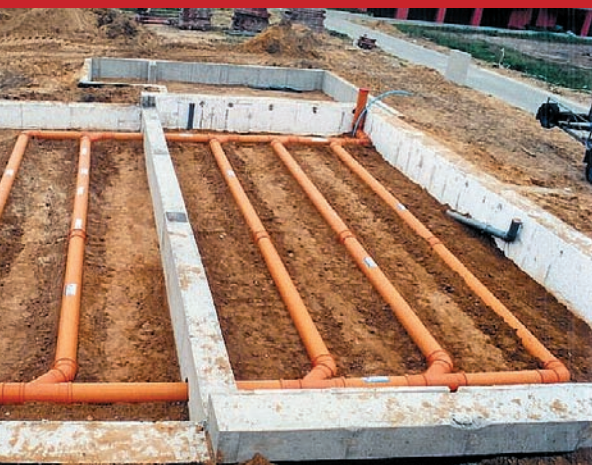
GWC na fundamentach pod domem
