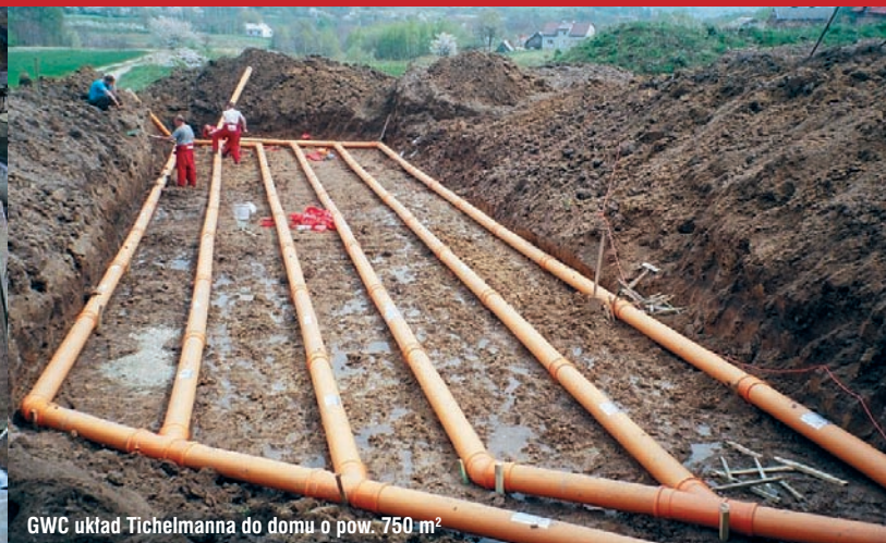
GWC w fundamentach pod obiektem handlowym
