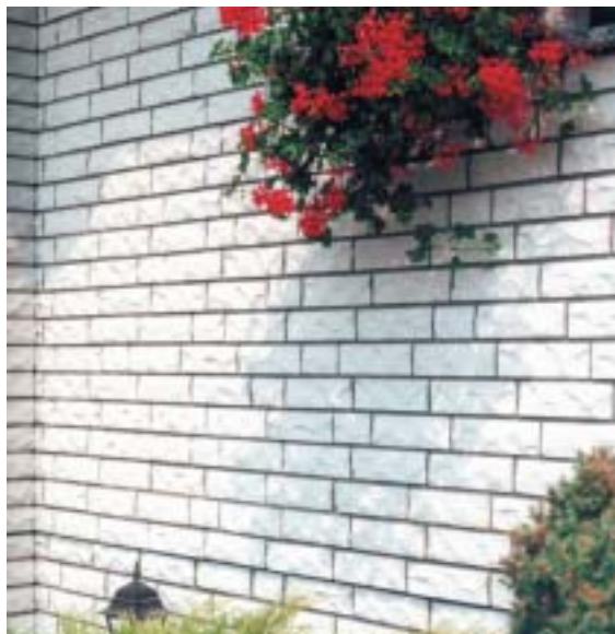
11 Ściany elewacyjne z silikatów z fakturowaną powierzchnią nie muszą być tynkowane (fot. Xella Vdb-Silka)
