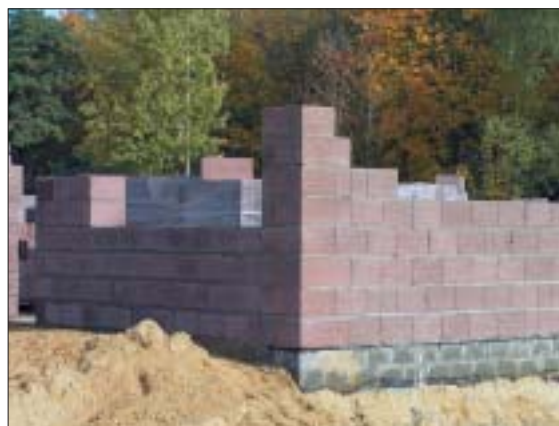
12 Budowa ścian nośnych z pustaków keramzytobetonowych (fot. Betard)
