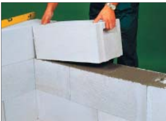
9 Budowa ściany jednowarstwowej z bloczków betonu komórkowego (fot. Prefbet)
