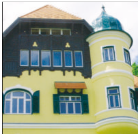
4 Okna z PVC mogą mieć niemal dowolny kształt (fot. Thermoplast)
