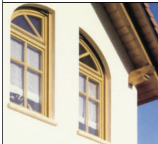
5 Szprosy dzielą szybę na mniejsze fragmenty (fot. Thermoplast)
