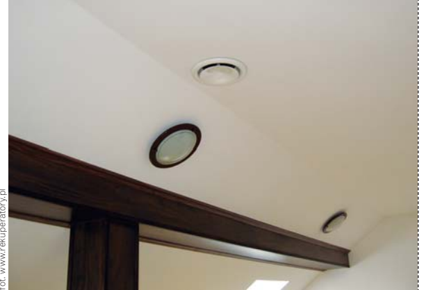
Projektant z doświadczeniem powinien pamiętać o zamontowaniu we wszystkich sypialniach, pokojach dziennych, salonie i gabinecie anemostatów, przez które będzie wwiewane do pomieszczeń świeże powietrze
