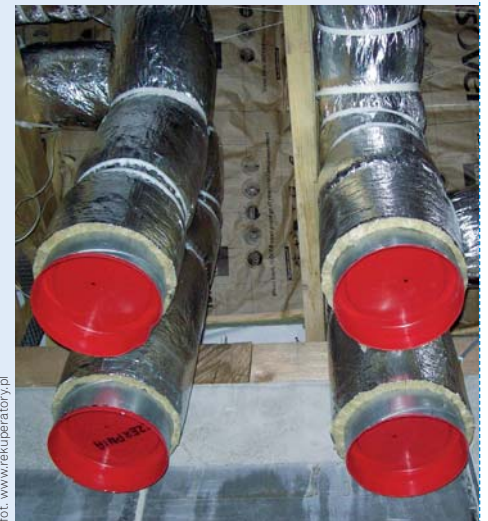
Stalowe przewody sztywne są droższe od elastycznych, ale zapewniają kilkudziesięcioletnią żywotność instalacji, a ponadto umożliwiają bezproblemowe jej czyszczenie
