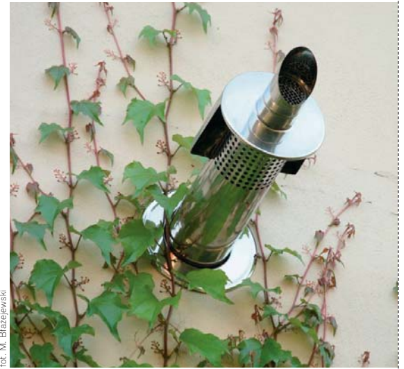
Spaliny z kotła kondensacyjnego mogą być odprowadzane przewodem powietrzno-spalinowym zamontowanym w ścianie
